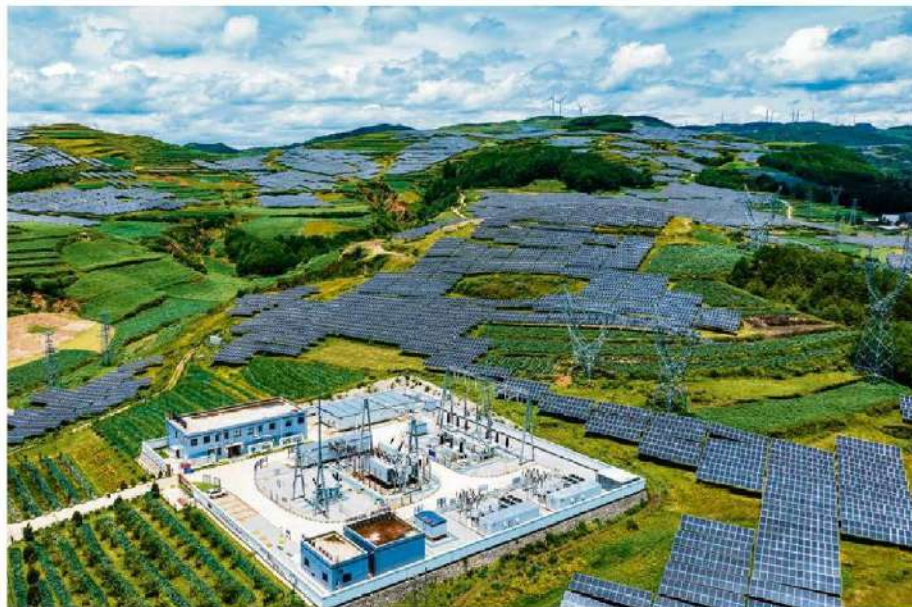
Centrale solaire à usage agricole, province du Guizhou (Chine), le 3 juillet. TAO LANG/XINHUA/APF
